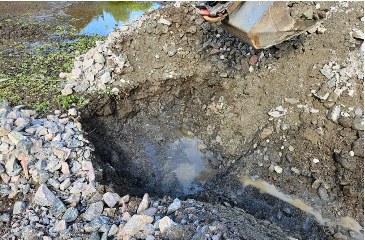
Figur 4. Brunnsschaktet. (Fotonummer: 2025-53-2). Foto: Patrik Hallberg.
